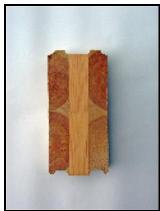
縦3層のラミネートログで、繊維方向を横(両側ラメラ)と縦(センターラメラ)に交差接着したログ。従って湿度によって約0.1%以上変化しない縦軸に近似した特性を実現。センターラメラを直に重ね、約2m間隔で5段ごとのボルトの締め付けによってセンターラメラ間のクリアランス(セトリング)を無くし、またスチールパイプの併用で、強力なログ合成壁を実現。特別な人工乾燥で含水率は12%前後としています。
